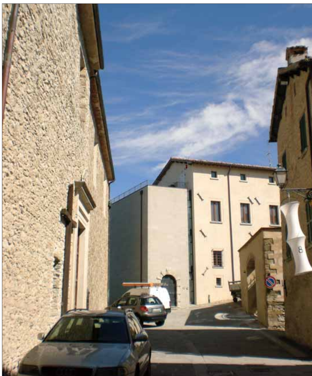
Come si presenta oggi il Palazzo, dopo i lavori di restauro
